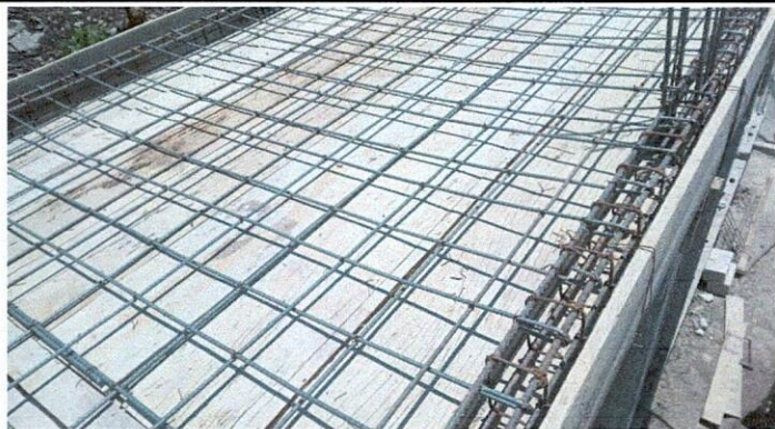
Foto 2: Remplazo para depósito de agua, Remozamiento en area de deposito de agua.
