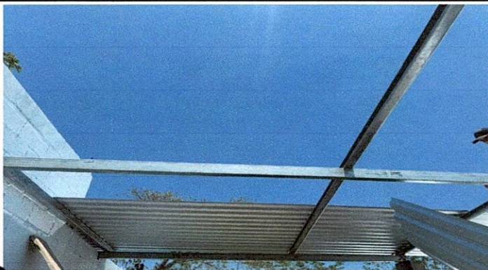
Foto1: Remplazo de estructura metalica con tubo de "2X4" y tubo de "3X3", sustitución de lamina (acanalada) por troquelada calibre 26, sustitucion de canal actual por canal aluzinc, calibre 26.
