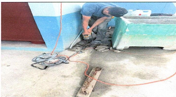
Foto 3: Remozamiento de tubería de drenaje y agua potable para pila.
