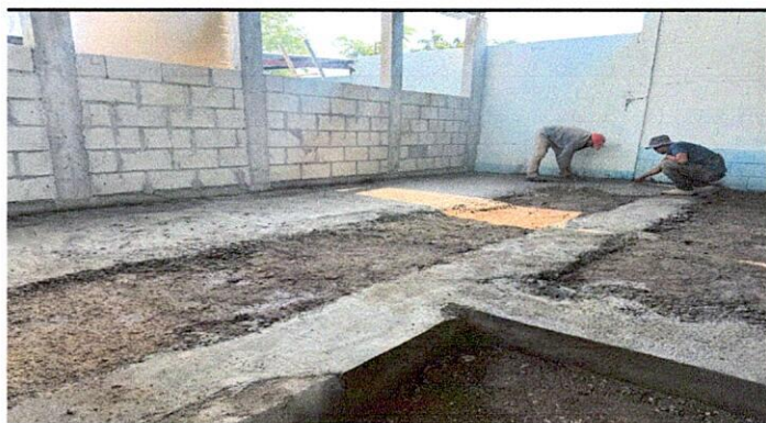
Foto 4: Sustitución de losa de patio
